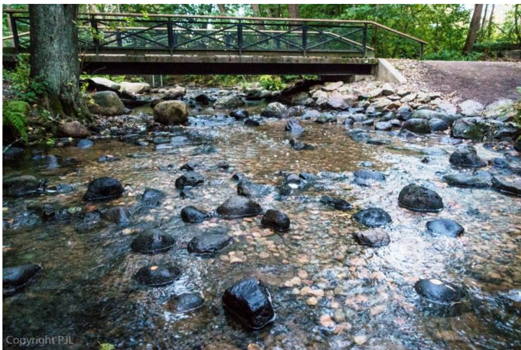
Saunakosken alaosa muutostöiden jälkeen
