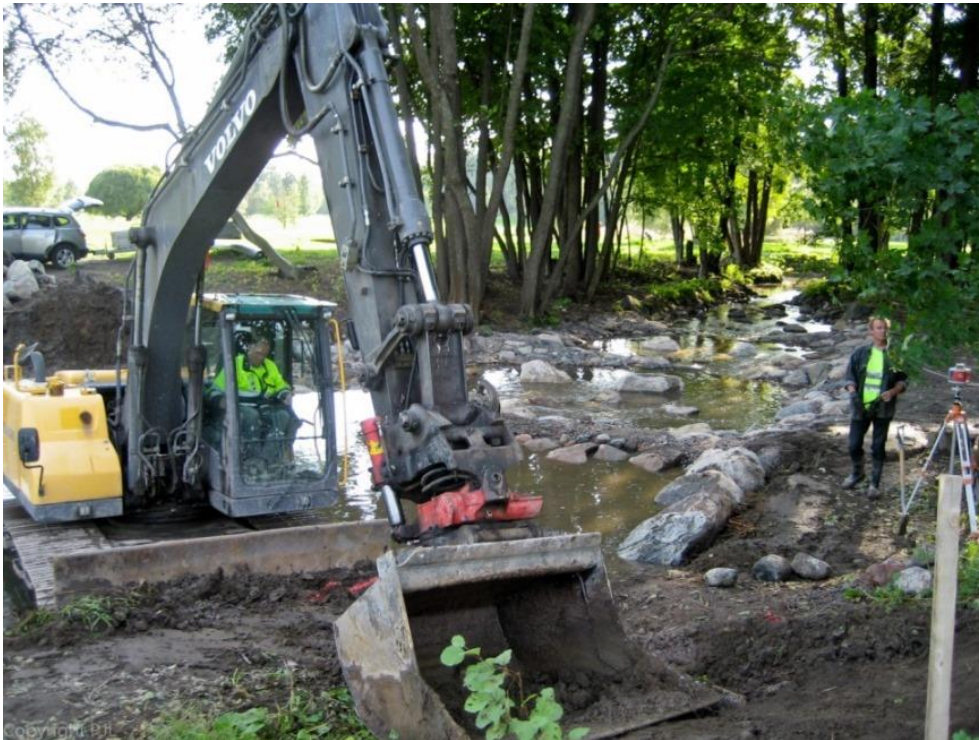
Koskea rakennetaan kesällä 2013
